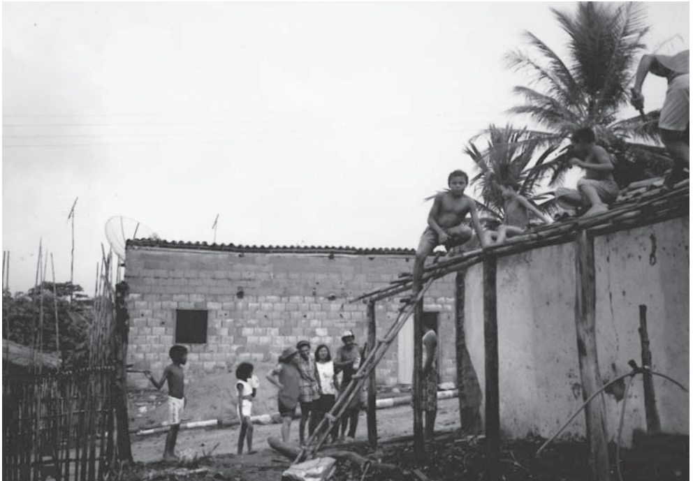
Ensemble pour réparer un toit
